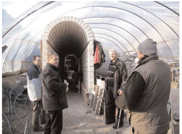
A szokásos heti műszaki ellenőrzés a helyszínen: (balról jobbra) Kerepesi Balázs, műszaki referens, Csomor Tibor, kivitelező, Sárkány Tibor, műszaki ellenőr, Földházi Lajos, építészvezető
